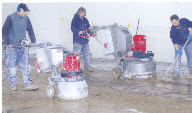
Natursteinbodensanierung in der Kirche St. Stephan in Dreieich von der Stoffaneller Gebäudereinigung und Management GmbH
