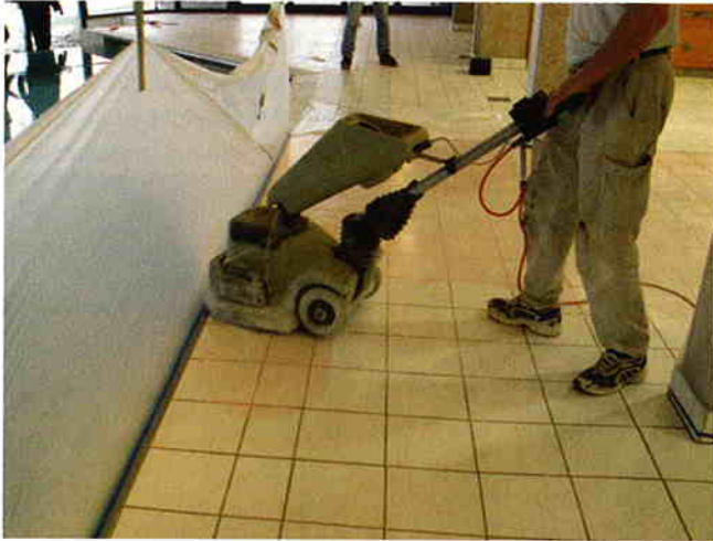
Sanierungsmaßnahme mit schwerer Einscheibenmaschine, rotem Superpad und „Kera nova“.
