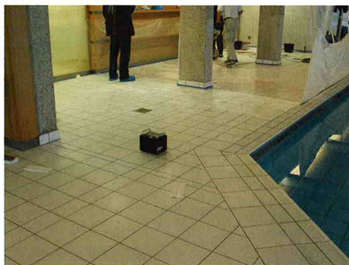
Messung des Gleitreibungskoeffizienten mit GMG 100 auf bereits sanierter Fliesenoberfläche. Im Hintergrund Schleifarbeiten auf abgeklebten Flächen.
